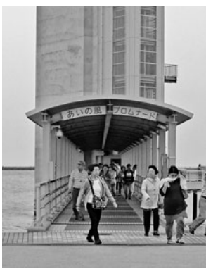
海上に浮かぶ空中歩廊
