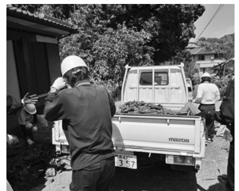
瓦ごみの撤去の様子
