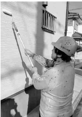
外壁の塗装工事をする藤田さん
